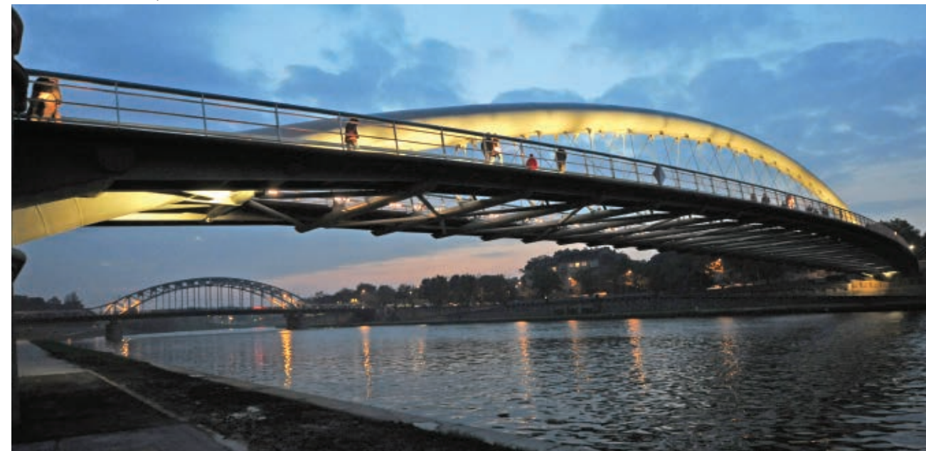
Kładka ojca Bernatka
