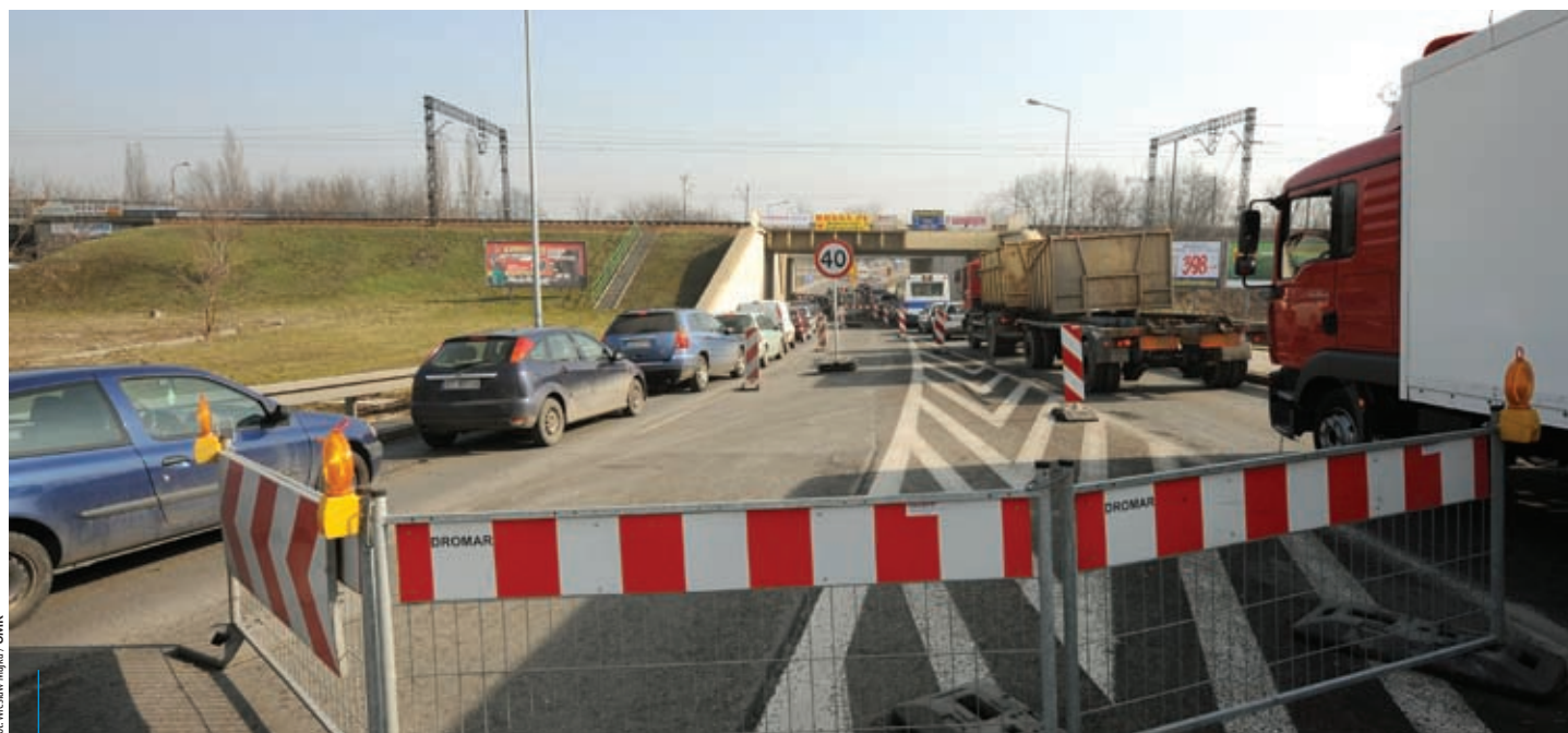
Trwa budowa szybkiego tramwaju do Golikówki. Trudno jeździć się ul. Nowohucką, ale cały zakorkowany rejon można ominąć objazdami.
