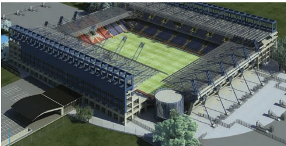
Planuje się, że 33 tys. widzów już w czerwcu zasiądzie na trybunach przebudowanego Stadionu Miejskiego im. Henryka Reymana.
